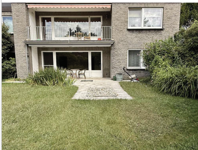
Rückansicht des Hauses
